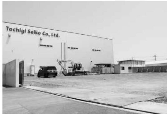
本社敷地内に注射針用新工場を建設する
